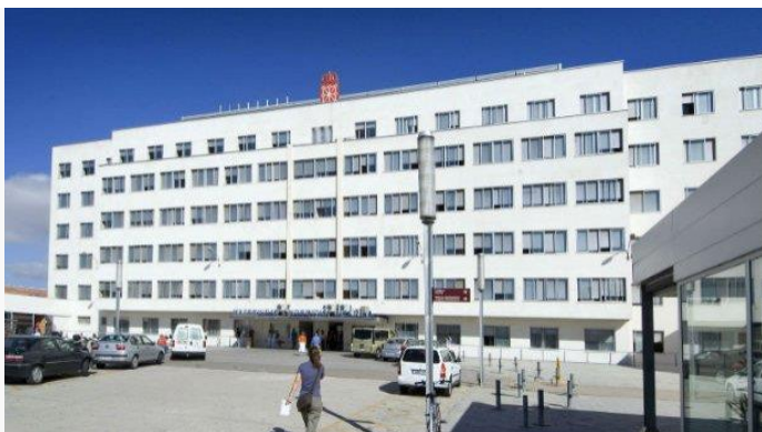
Fachada del Complejo Hospitalario de Navarra. (Gobierno de Navarra)
